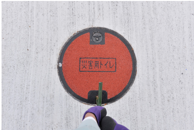
専用バールをロック部に差し込む
