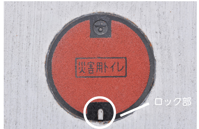
トイレ用マンホール蓋に「災害用トイレ」の文字があることを確認します
