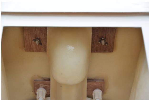
蝶ネジでロータンクと便器を固定
