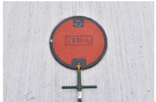
専用バールを下方方向に動かし、蓋を浮かせる
