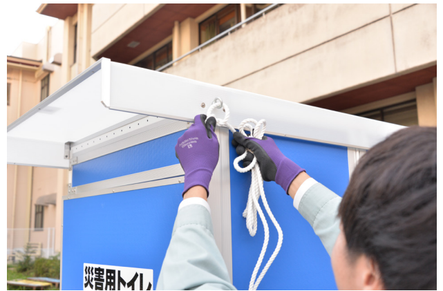
屋根固定ボルトにロープを結ぶ（4 か所）
