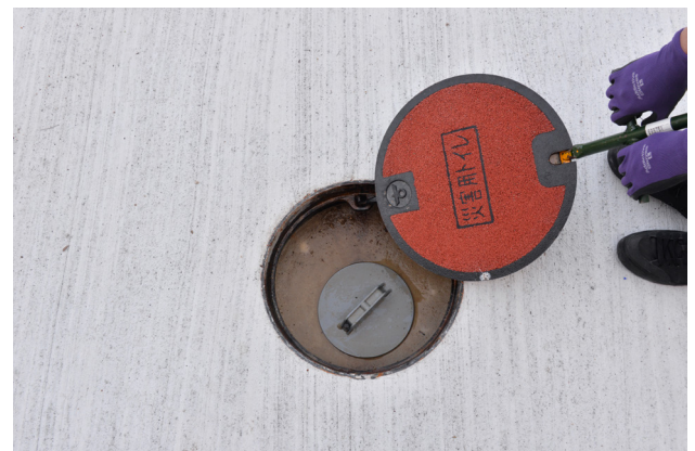
蓋を引き上げた状態で 90° 旋回させる
