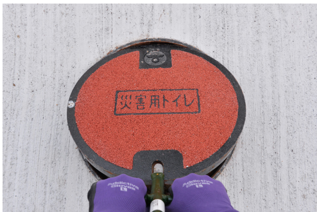
専用バールで蓋を引き上げる
