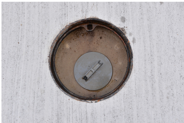
蓋枠から蝶番を外し、蓋が開いた状態にする
