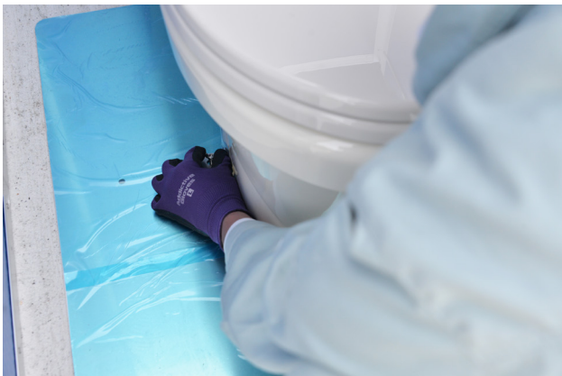
床板と便器を接合し、保管していた蝶ネジで 固定
