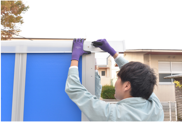
屋根の四隅をボルトで上屋と固定する
