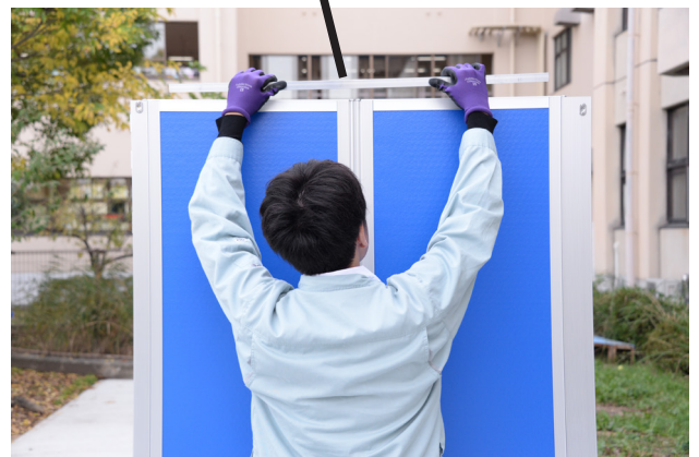
上屋（パネル）上部にCチャンネルを差し込み、上屋を真っ直ぐな形にします
