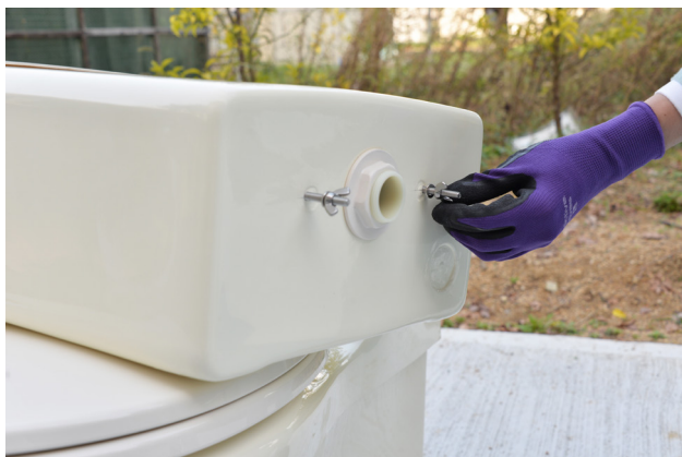
ロータンク部の裏面の蝶ネジを外す ※蝶ネジは直後に使用
