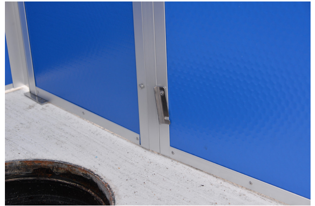
内部の金具を固定する
