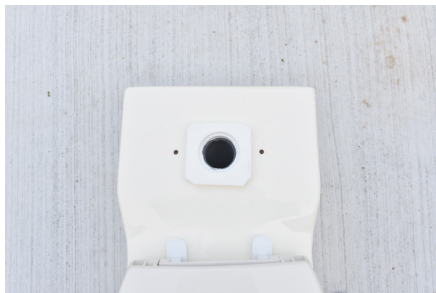
ロータンクと便器を接続する
