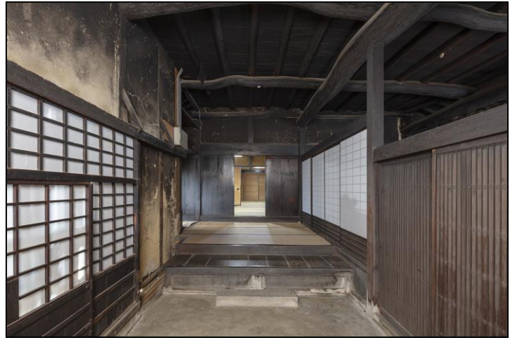
土間（入口）から五畳半寄付、 八畳座敷（玄関北側）を望む
