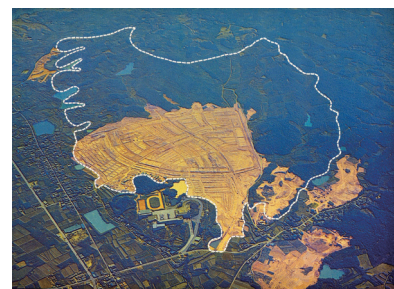
図 45 狭山ニュータウン第1期 造成工事 (昭和 43 年 (1968))
