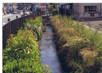
●第一幹線水路/清掃前
