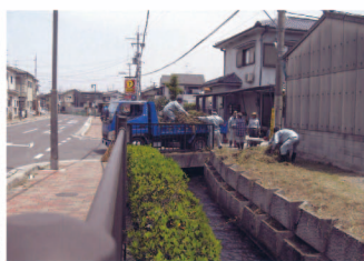
●第一幹線水路/清掃後
