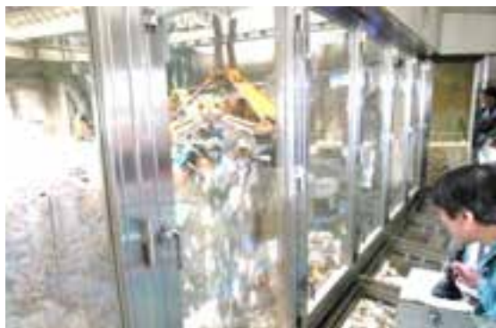
ごみの攪拌作業
