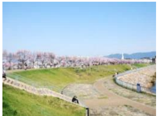
狭山池北西側の堤防(27年3月)
