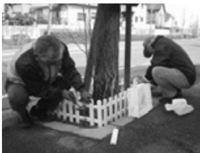
柵の修理作業
