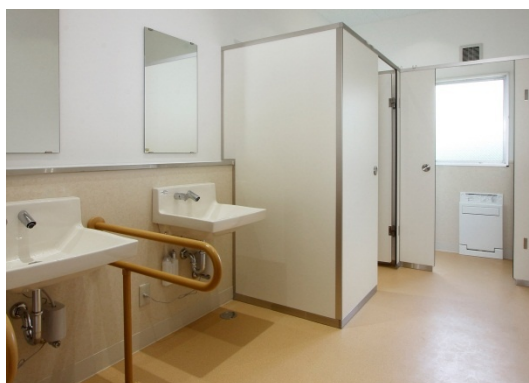
南第一小学校 職員トイレ
