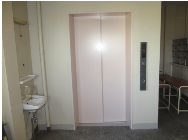
東小学校 エレベーター扉
