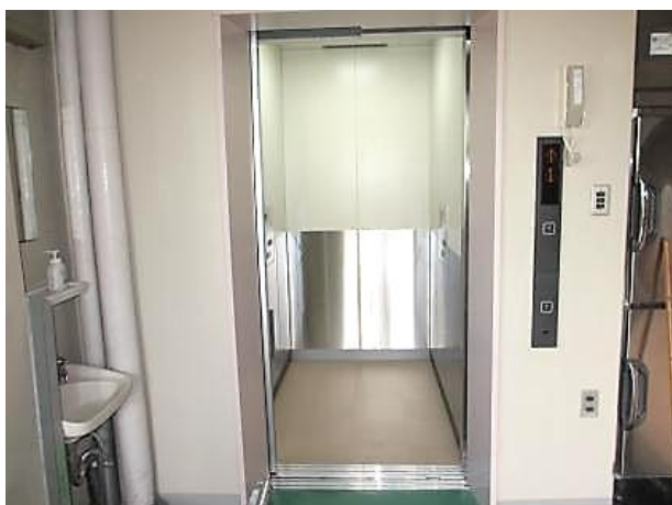
東小学校 エレベーター内部
