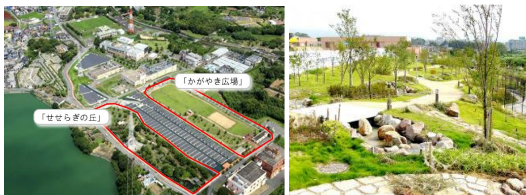
図 2-5 狭山水みらいセンターと処理場内の修景施設（せせらぎの丘）
