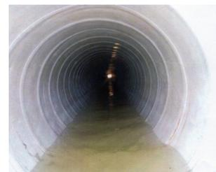
・老朽化した下水道管の内面に更生管を築造し施設の長寿命化を図っています。
