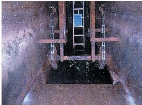
ポンプ場沈砂池(改築工事前)
