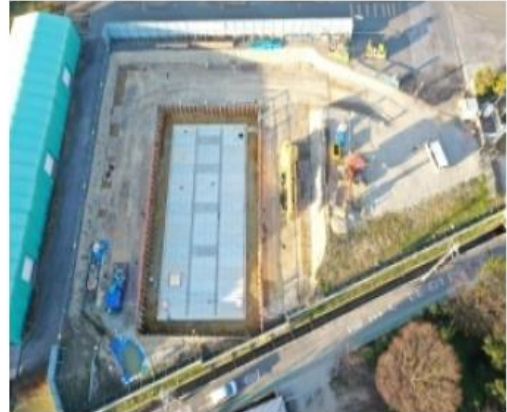
埋め戻し前（上空写真）
