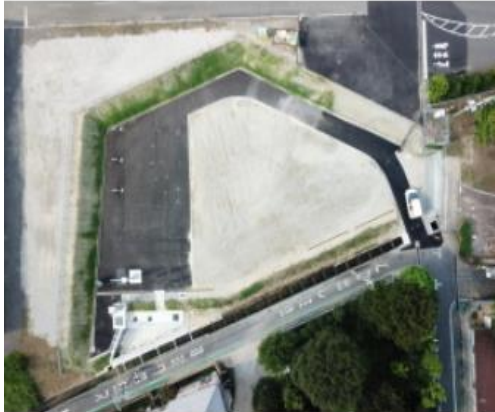
完成（上空写真）
