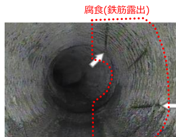
下水道管内の状況
