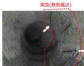
下水道管内の状況
