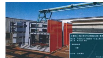
工場での推進機仮組の様子
