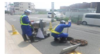
カメラ調査状況
