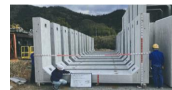
工場での函体完成検査の様子
