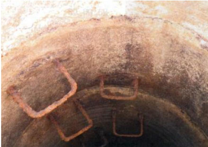
劣化したマンホール内の腐食した取手部分
