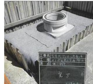
※下水道本管が被災した場合でも**一時貯留可能**。調査・修繕期間の流出不可を想定し、**吸引車の対応が可能で衛生的な環境を維持**します。
