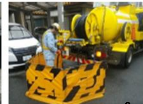
清掃車による下水道本管の清掃
