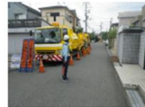
清掃車による下水道本管の清掃
