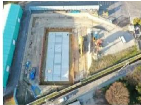
工事中（上空写真）
