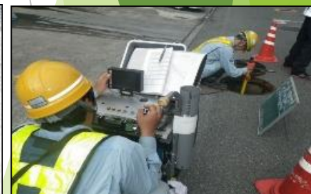
管口カメラによる管内状況の確認
