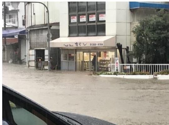
浸水被害状況
