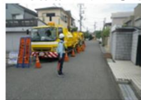
清掃車による下水道本管の清掃
