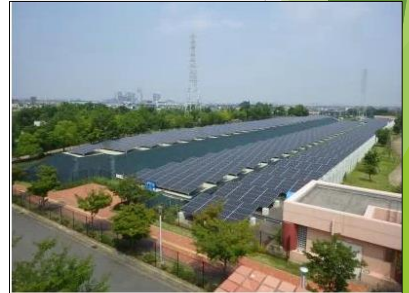
狭山水みらいセンター
