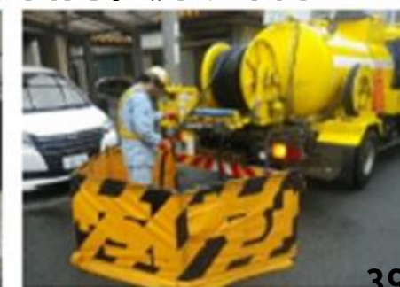
清掃車による下水道本管の清掃
