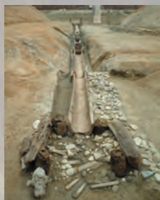
▲発見された東樋
