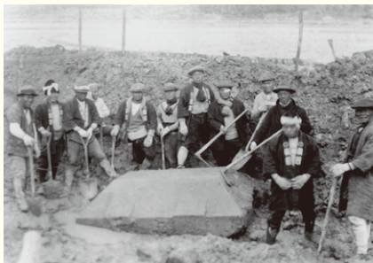
大正・昭和の改修の時に狭山池で発掘された石棺蓋
