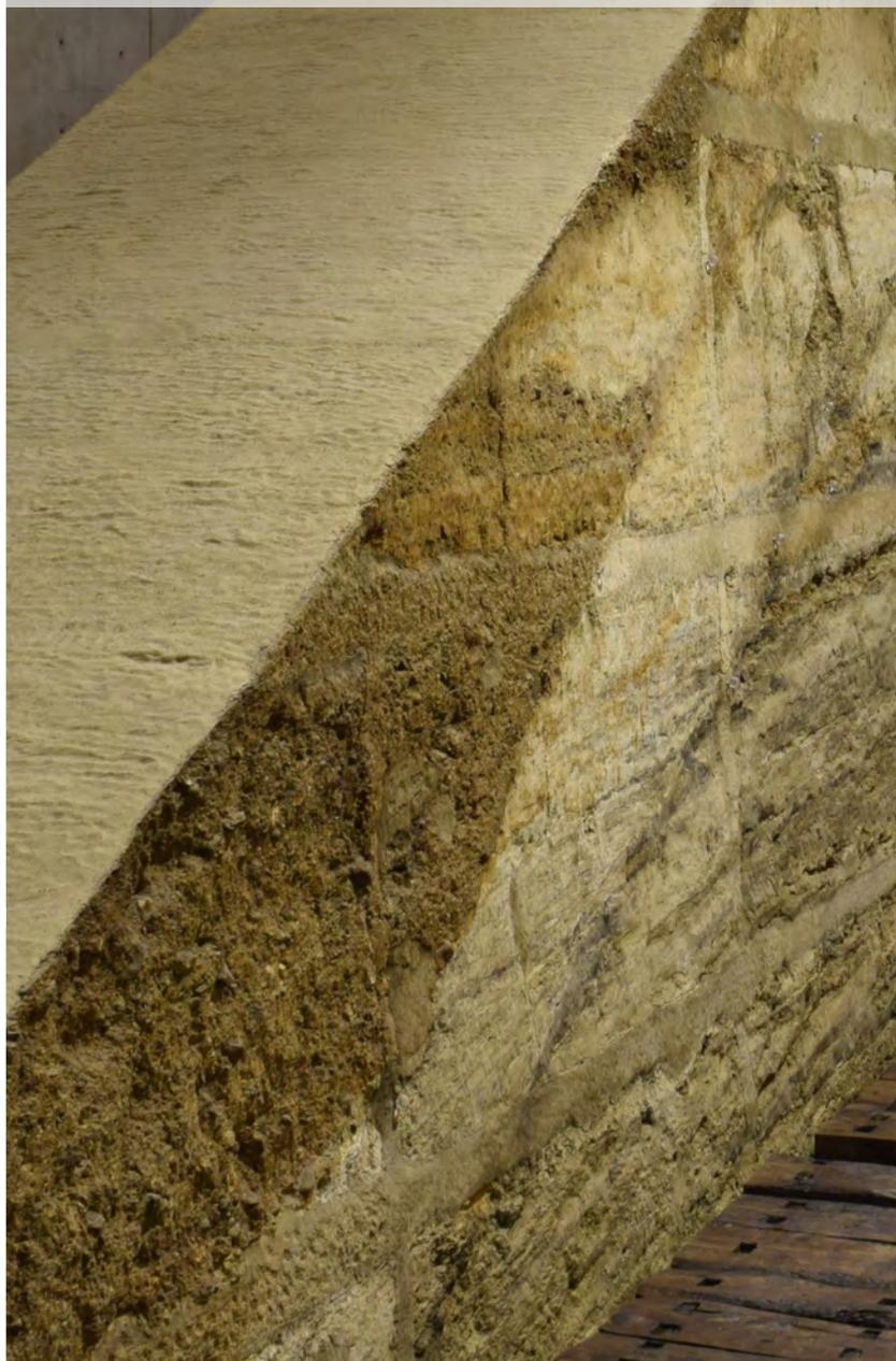
高さ15.4メートルにもなる実際の堤防の一部を切り取って展示された堤の断面は、1400年間の改修の跡が見て取れる
