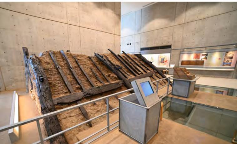
江戸時代にできた、地滑りで堤が崩れるのを防ぐための「木製粹工」。これと下の取水塔は、先に設置してから周りに建物が建設された
