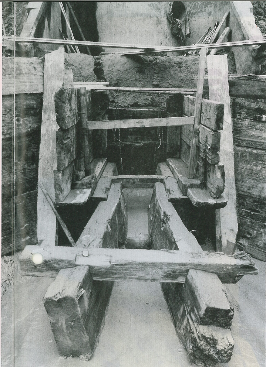
▲中樋の四段目部分を検出
