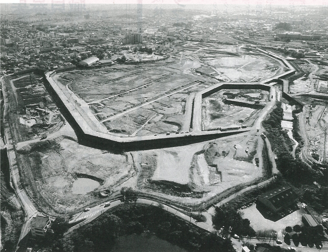
▲着々と工事が進む狭山池(産経新聞社提供)
