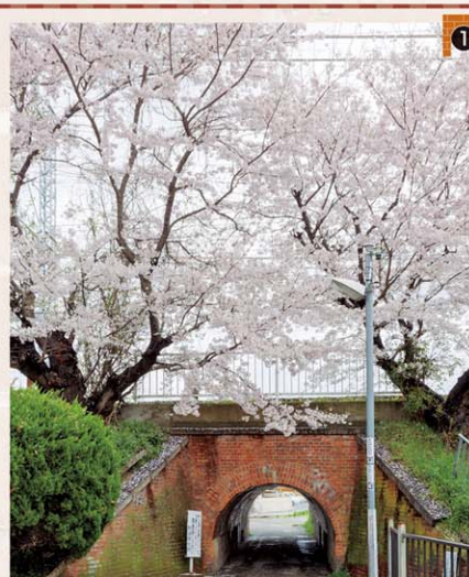
一號暗渠（第40號狹渠）MAP E-4 設計成半圓拱門，通道的地下設有從狹山池流向大池的水路。
