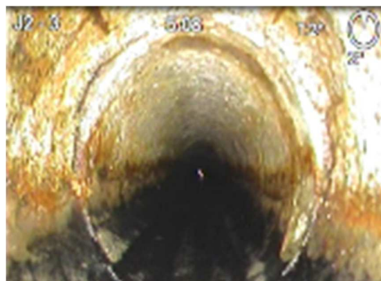
既設老朽管渠
