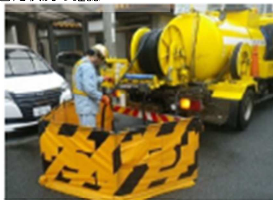
清掃車による下水道本管の清掃
