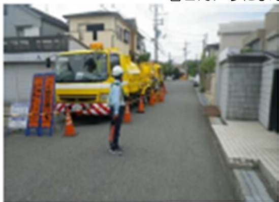
清掃車による下水道本管の清掃
