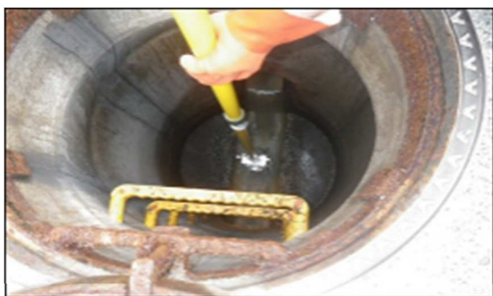
管口カメラによる管内状況の確認
