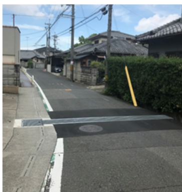
池之原三丁目地内水路改修工事
