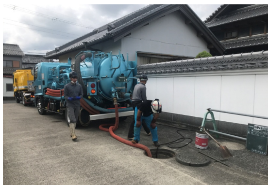
農業用水路道路横断管清掃業務
