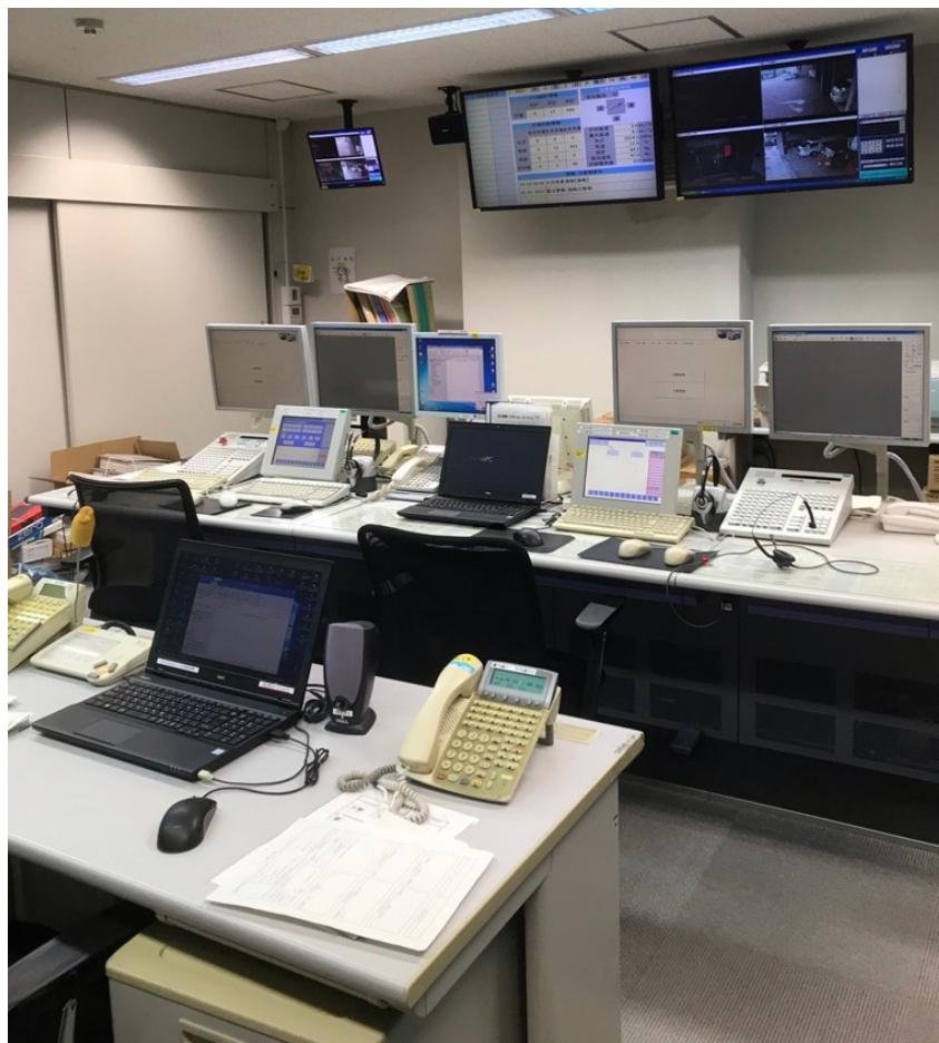
消防救急デジタル無線保守点検業務 1式 8,250,000円
