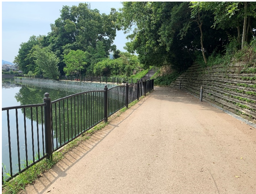
(副池オアシス公園園路改修工事)
