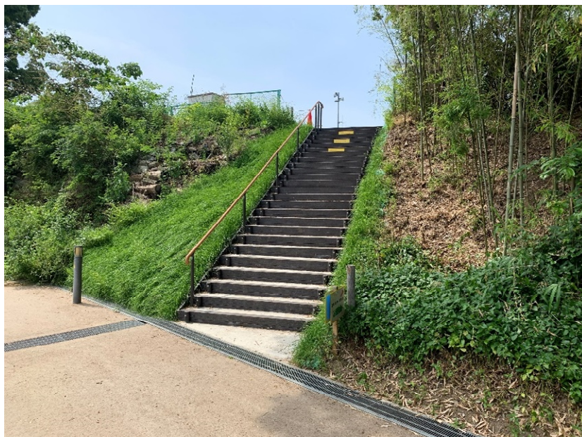
(副池オアシス公園園路等整備工事)
