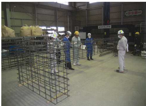
雨水調整池整備工事の材料検査の様子
