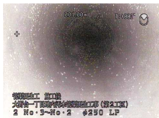
更生後の管渠
