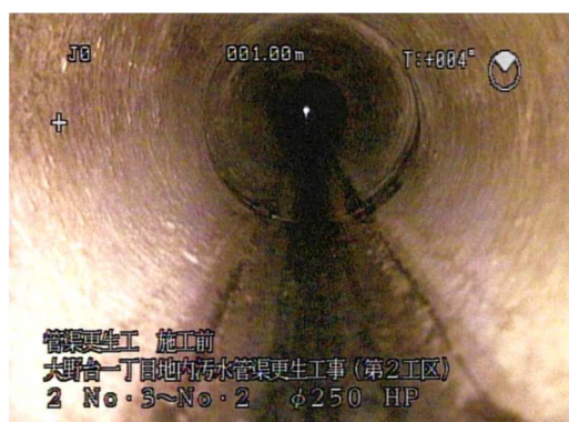
既設老朽管渠
