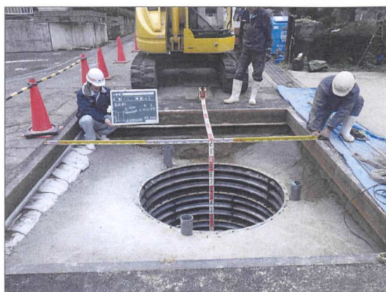
雨水管渠の整備工事の様子
