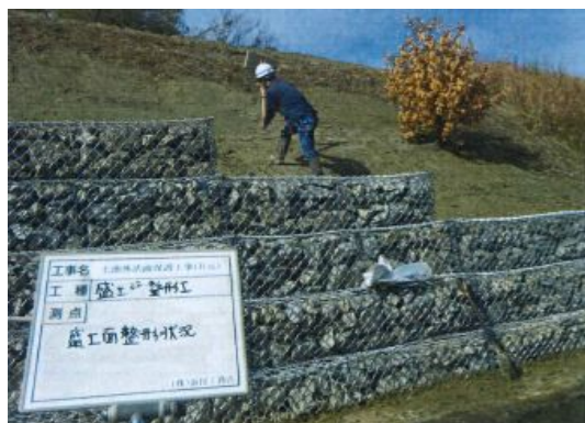
七池外法面保護工事
