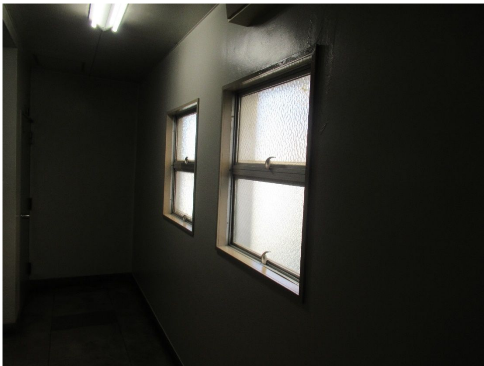
庁舎中央階段室改修工事 112,320 円
