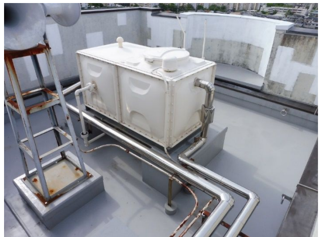
屋根防水改修工事 1,414,800 円
