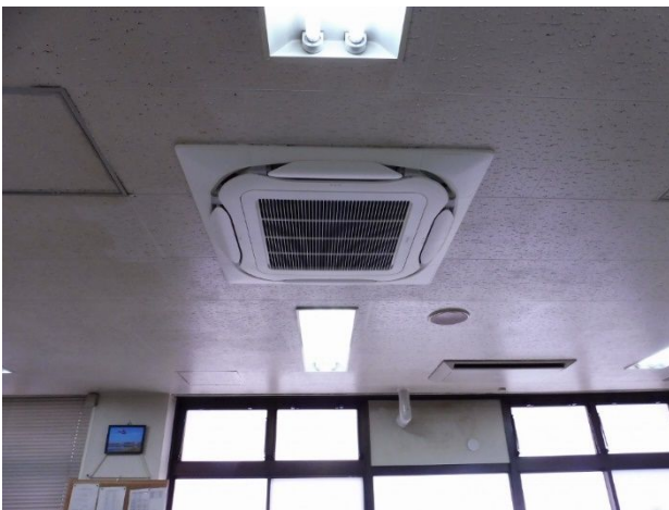
空調機設置工事 813,240 円
