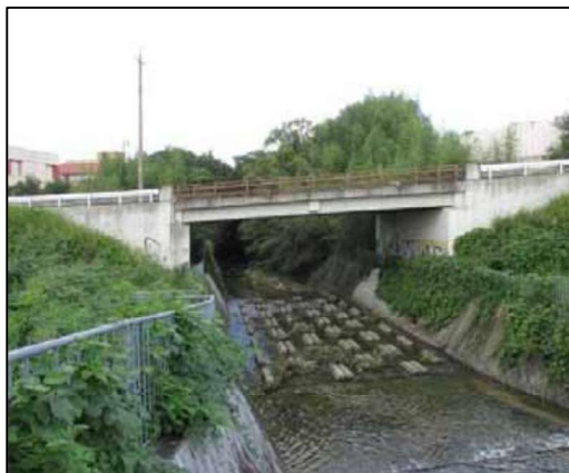
東除川に架かる大鳥池橋
