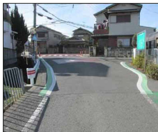
水路をまたぐ無名橋（市道東野南側線）
