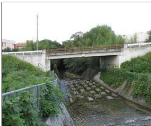
東除川に架かる大鳥池橋
