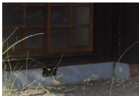
コンクリート基礎等（評点 0）
