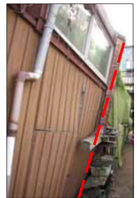
柱の変形が著しく崩壊の危険がある例 (100点)
