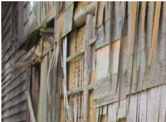
事例）著しく下地が露出（評点25）
