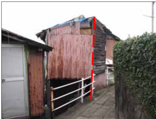
一部の柱が傾斜している例 (25点)
