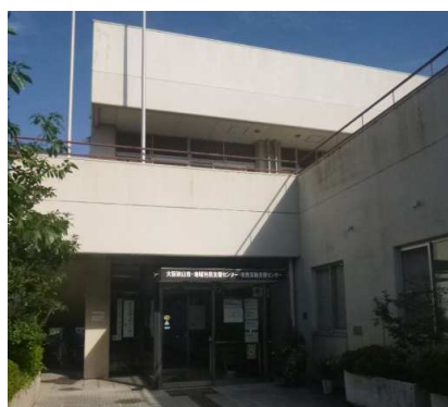
市役所庁舎南館
